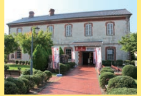
日本一古い旧長浜駅舎
